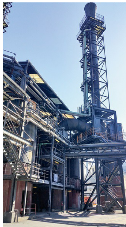
El dióxido de titanio se fabrica en las primeras fases del proceso según el procedimiento al sulfato.
