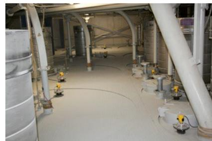
Cada uno de los silos dispone únicamente de un VEGAPULS 69, que sustituye al pesaje utilizado hasta ahora.
