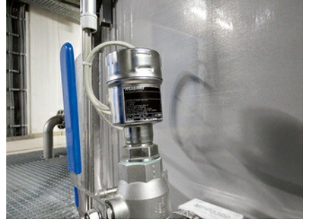
VEGABAR 82 ve "Second Line of Defense" ile donatılmış ölçüm noktası.
