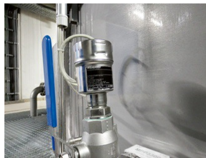
Point de mesure avec VEGABAR 82 et Second Line of defense.
