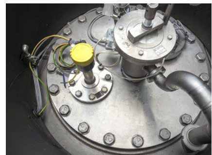
Das Radarfüllstandmessgerät VEGAPULS 64 übernimmt die Inhaltsmessung.
