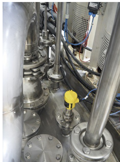
De radarniveausensor VEGAPULS 64 meet betrouwbaar het niveau in de productielijnen.
