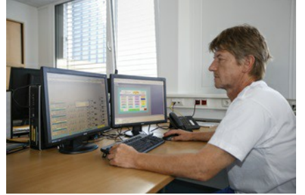
Malzeme ve enerji akımları, elektrik teknisyeni Martin Schneider'in kontrolü altında.
