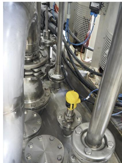
Lo strumento di misura di livello radar VEGAPULS 64 misura in maniera affidabile il livello negli impianti di produzione.
