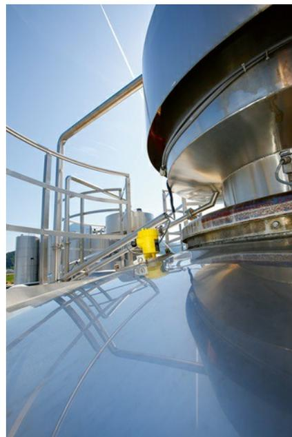
Le VEGAPULS 64 mesure avec fiabilité le niveau des cuves de lactosérum.
