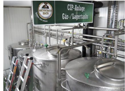
Weitere Druckmessumformer kommen im CIP-Tank zum Einsatz.
