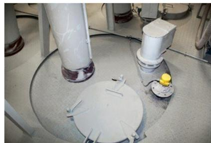
Cette photo montre bien l'étréitesse des silos et la raison pour laquelle le VEGAPULS 69 séduit par son angle d'émission très réduit : il n'y a presque pas de place pour monter l'appareil.
