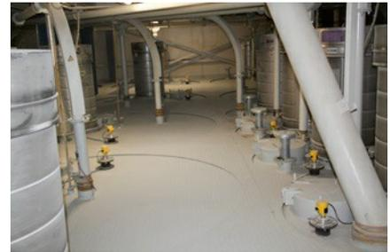
Jedes der Silos verfügt nun über einen VEGAPULS 69, der die bisherige Siloverwiegung ersetzt.
