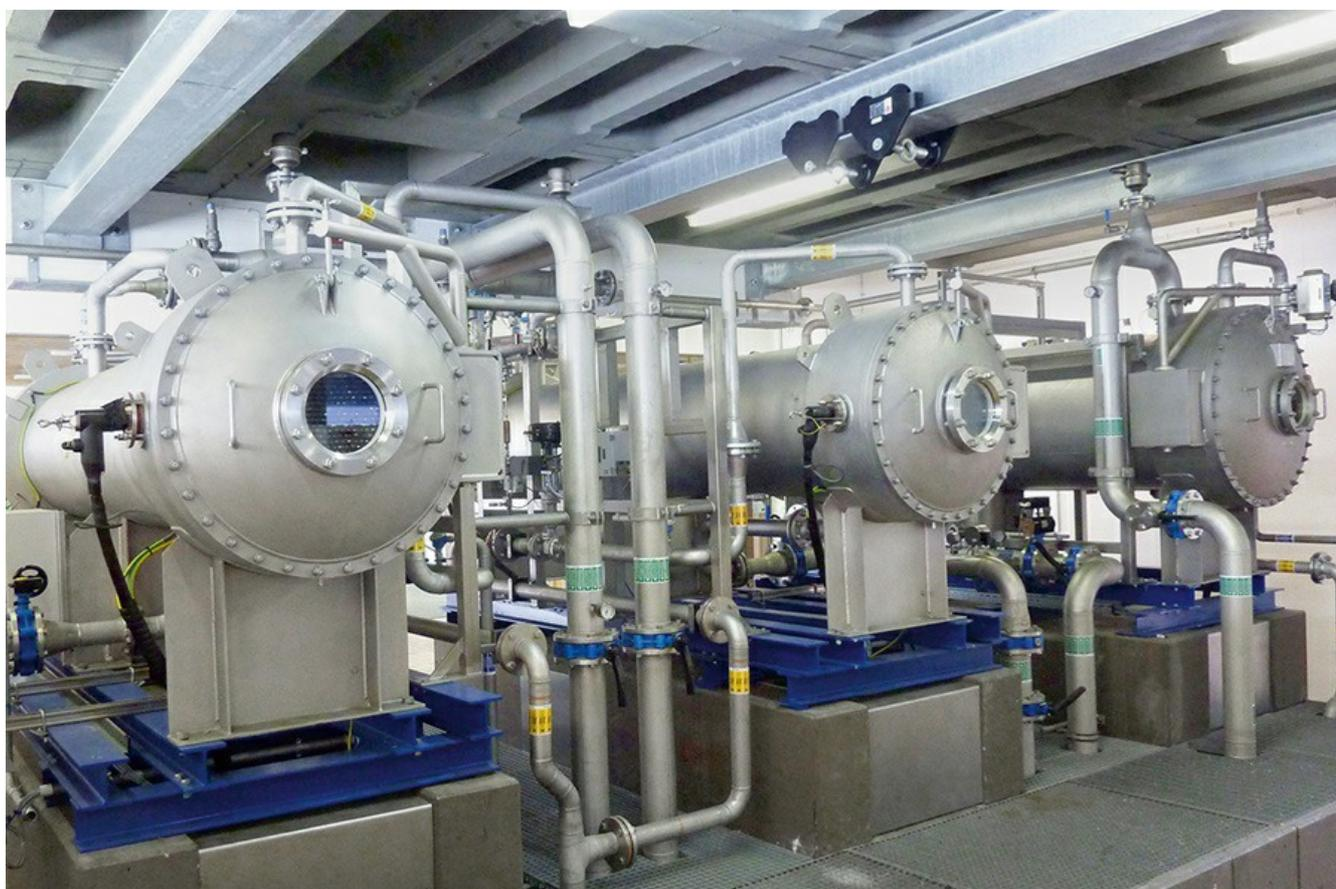
Los generadores de ozono garantizan la seguridad en la producción de agua potable.
