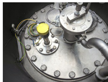
Le capteur radar VEGAPULS 64 assure la mesure du niveau.
