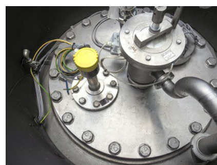
El instrumento de medición de nivel radar VEGAPULS 64 se encarga de medir el contenido.
