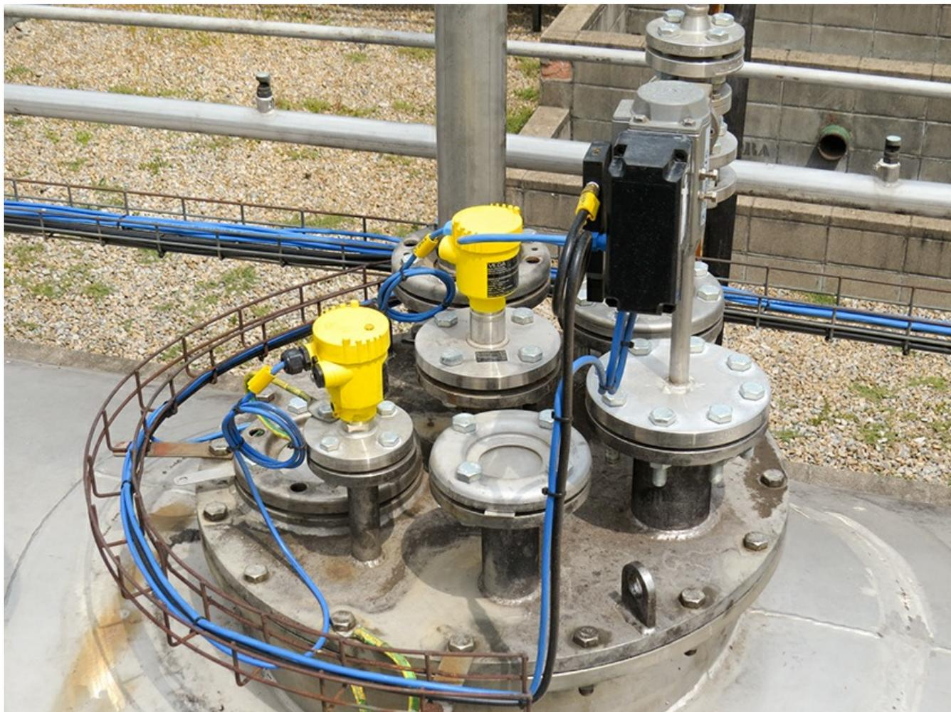
Le faisceau radar très étroit du capteur permet le montage même en présence d'éléments métalliques.
