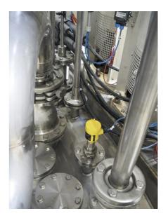
Lo strumento di misura di livello radar VEGAPULS 64 misura in maniera affidabile il livello negli impianti di produzione.
