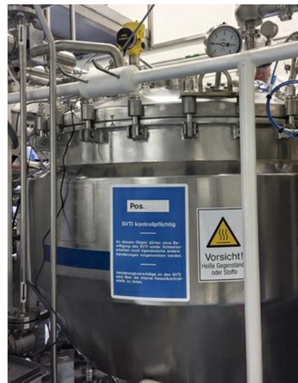
La longueur d'onde très courte des capteurs radar VEGAPULS 64 permet d'assurer une mesure ultraprécise du niveau pendant tout le process.
