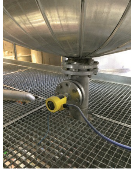
Bir damıtma tankında yapılan elektronik fark basınç ölçümünde kullanılan anabirim sensör.
