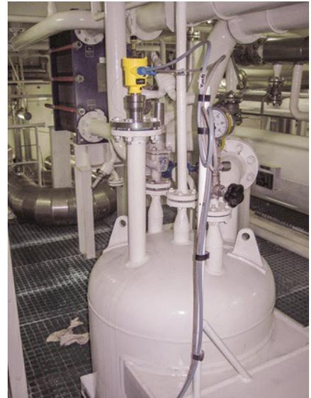
Der VEGAPULS 64 misst den Füllstand in einem Kühlsystem an Bord eines Gastankers.
