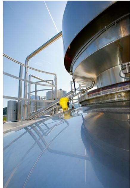
Der VEGAPULS 64 misst zuverlässig den Füllstand in den Molketanks.
