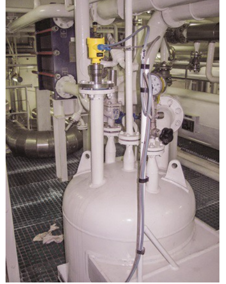
VEGAPULS 64 bir gaz tankerindeki soğutma sisteminde seviyeyi ölçüyor.
