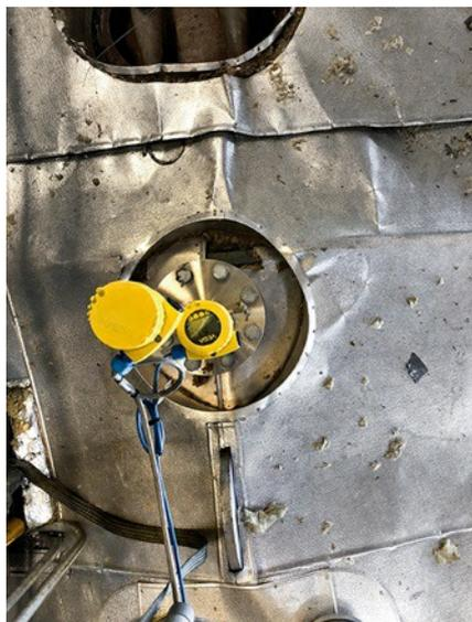
Una brida combinada maciza con tapa de brida ciega y una robusta rosca de tornillo instaladas en la caldera aúnan dos de los instrumentos de medición necesarios para el proceso en una conexión. Con los valores determinados mediante los estados actuales del proceso, esta combinación proporciona seguridad, ya que ambos transmisores se confirman mutuamente la plausibilidad de sus resultados.
