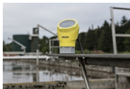
VEGAPULS con indicazione sul posto.
